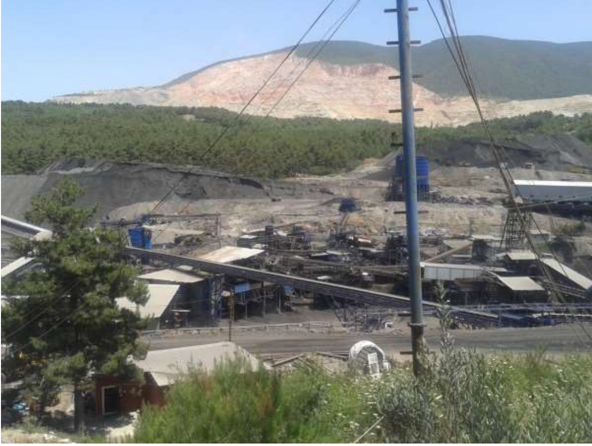
Şekil 7. İmbat Madencilik lavvar tesisi. Eynez Yeraltı İşletmesi
