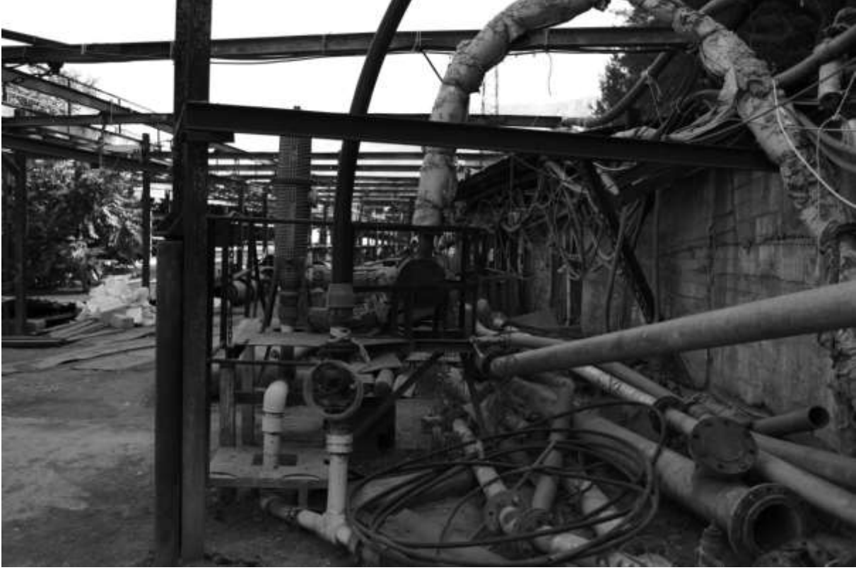
Şekil 5. Soma Kömürleri A.Ş.’nin işlettiği ve kazanın meydana geldiği Eynez Yeraltı İşletmesi’nin girişi etrafında dağınık bir durumda duran çeşitli malzemeler.
